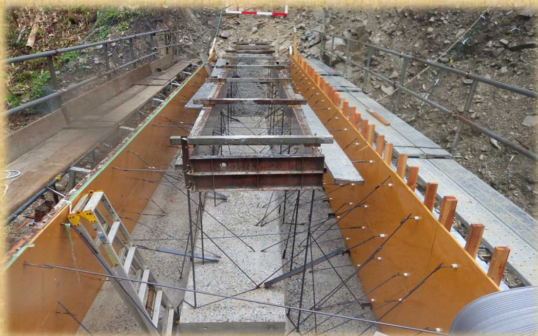
コンクリート用型枠(堤底内)
