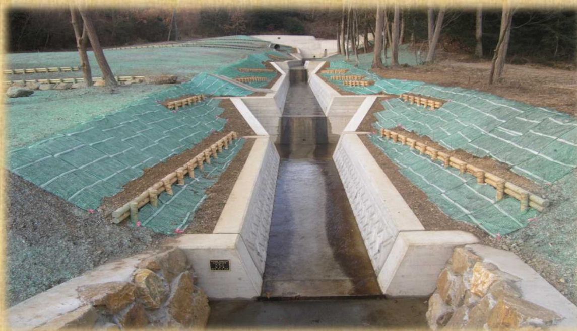
丸太筋工(近景)
