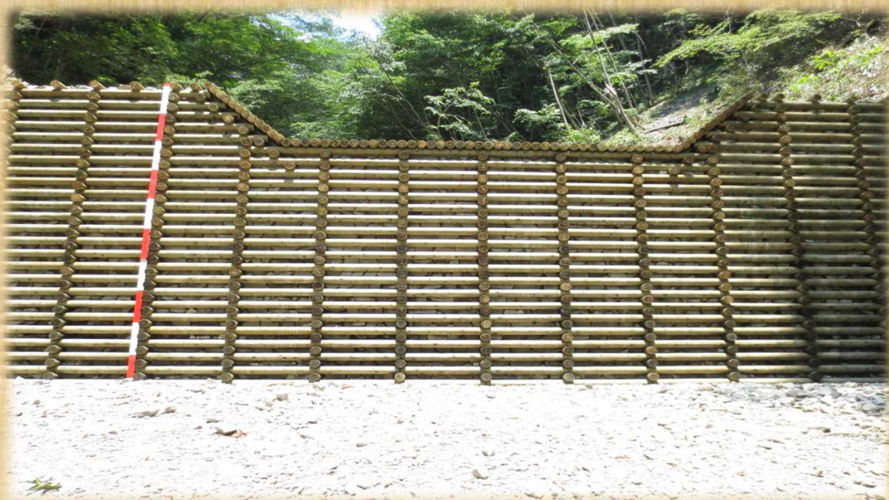
木製校倉式谷止工(高耐久処理丸太使用)
