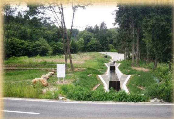
丸太筋工(遠景)
