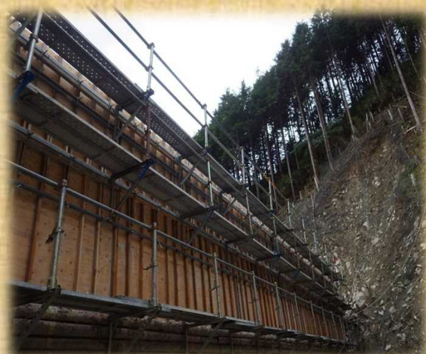
コンクリート用型枠(上流側)
