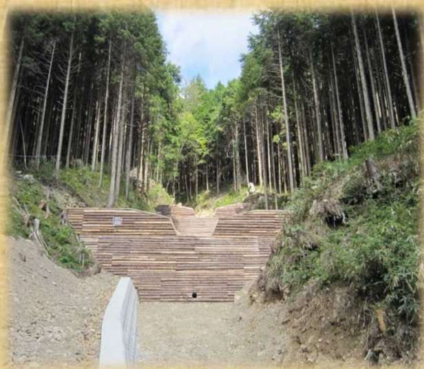
コンクリート谷止工(丸太残存型枠使用)
