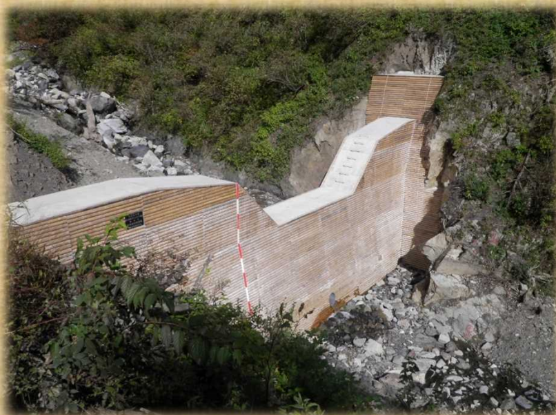
コンクリート谷止工(丸太残存型枠使用)
