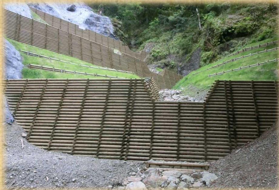
木製校倉式土留工(高耐久処理丸太使用)
