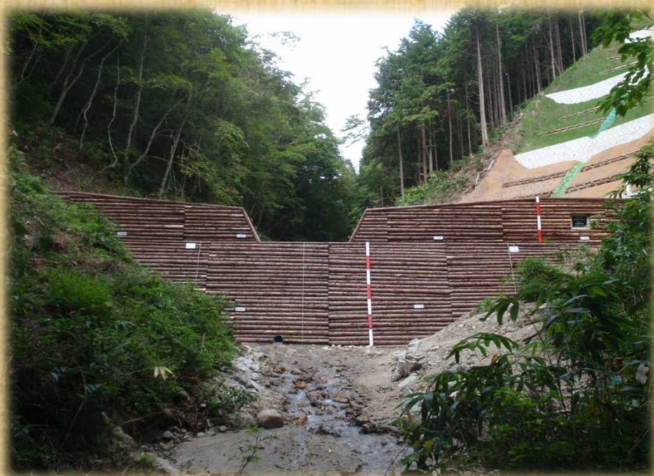
コンクリート谷止工(丸太残存型枠)
