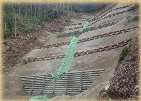
木製校倉式谷止工(高耐久処理丸太使用)
