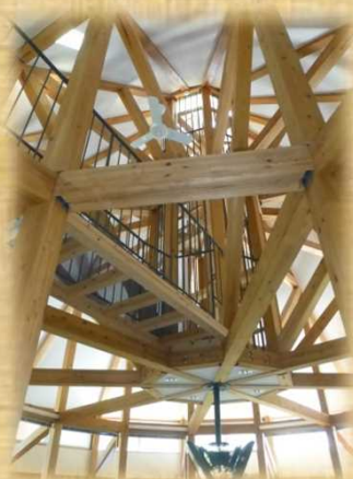
コンピュータ室天井
