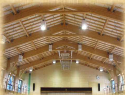
屋内運動場の天井 (大断面集成材を使用)
