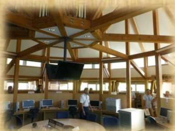
コンピュータ室・図書室
