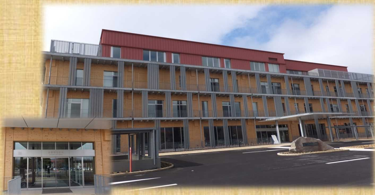
正面玄関外観
