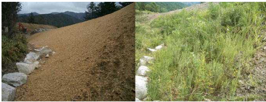
林地残材を活用した木材チップ吹き付け（吹付時と2年後の比較）
