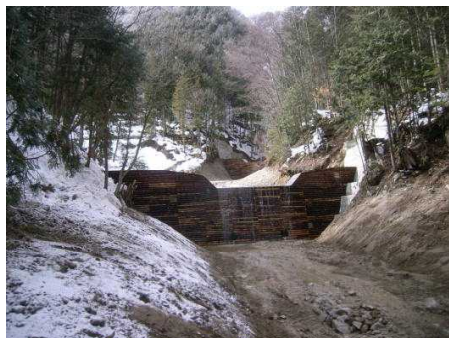
間伐材を利用した堰堤
