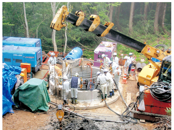
地すべり防止工事の集水井の見学
