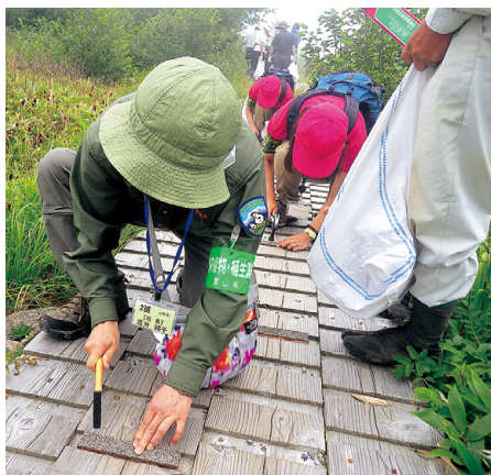
滑り止め板を設置作業中
