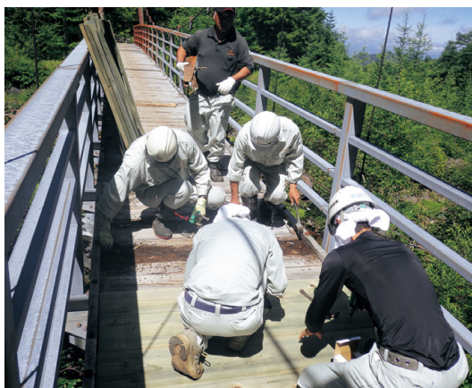
仙人橋の床板張替作業
