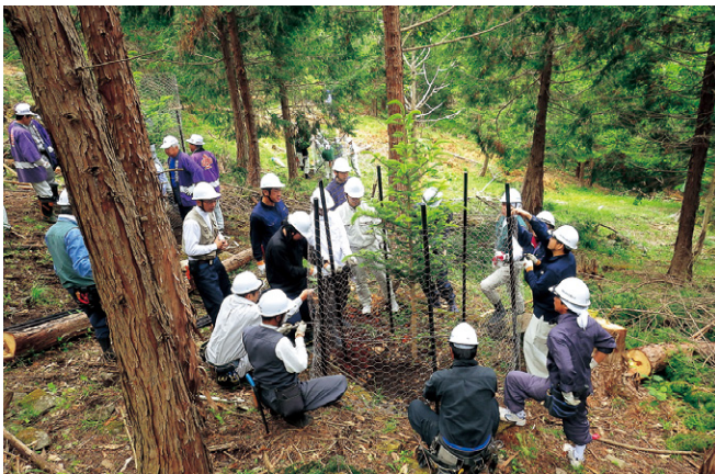
食害防止の金網ネット設置
