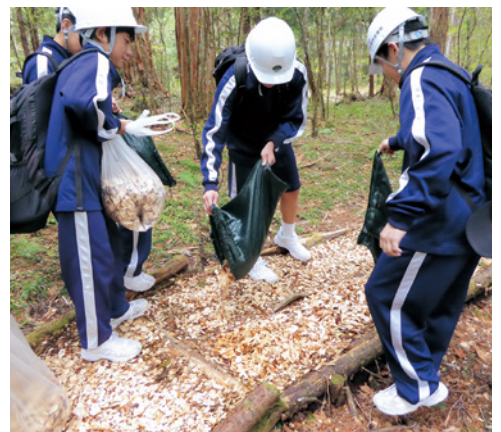
遊歩道の木質チップ敷設作業
