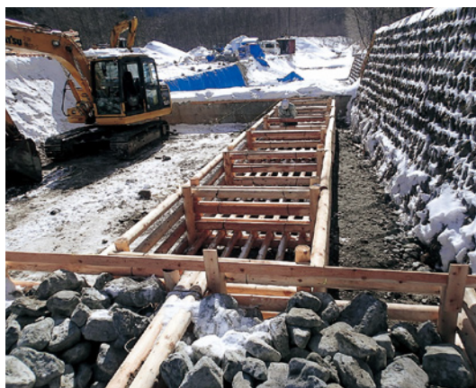
玄文沢【上高地】工事実行状況（1月中旬）
