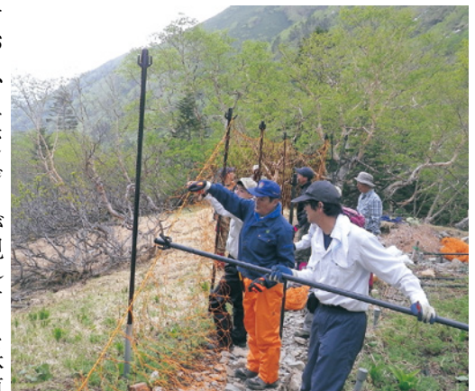
防鹿柵ネット張り替え作業の様子
