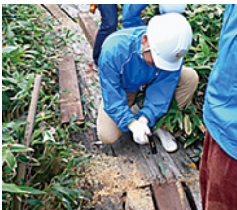
木道の張り替え作業
