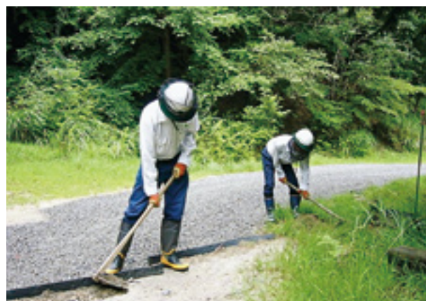
止水エース補修維持作業
