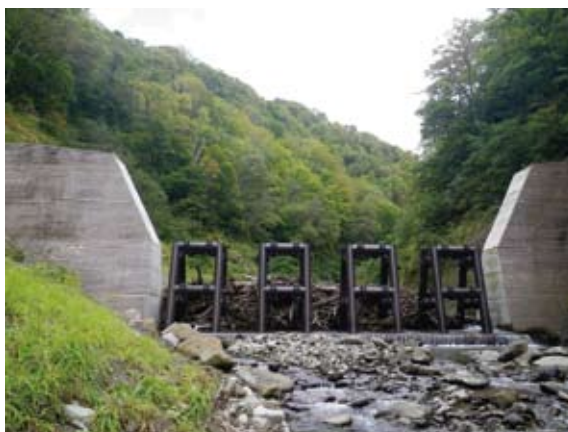
生物多様性に配慮した溪間工
