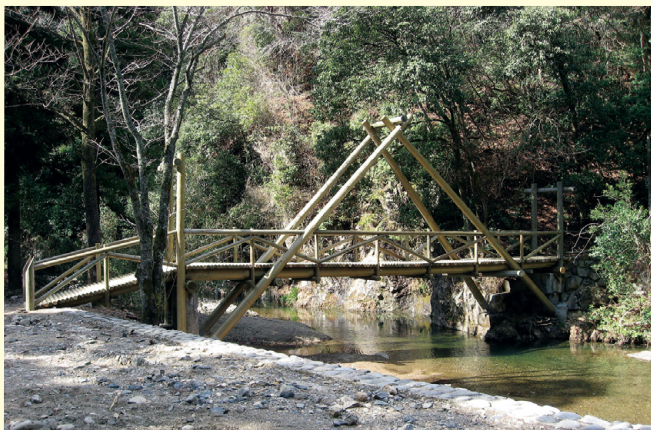
復元された八曾木橋
