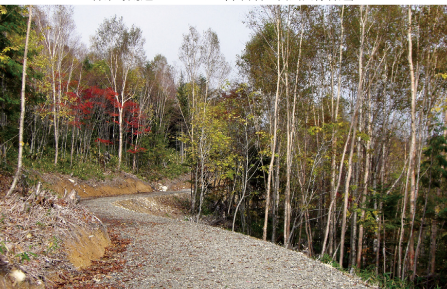
林業専用道のイメージ（木曾署：白川支線林道）
