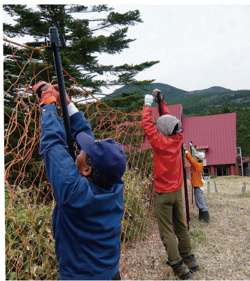
高山植物を保護する防護柵の設置 (東信署・南信署)
