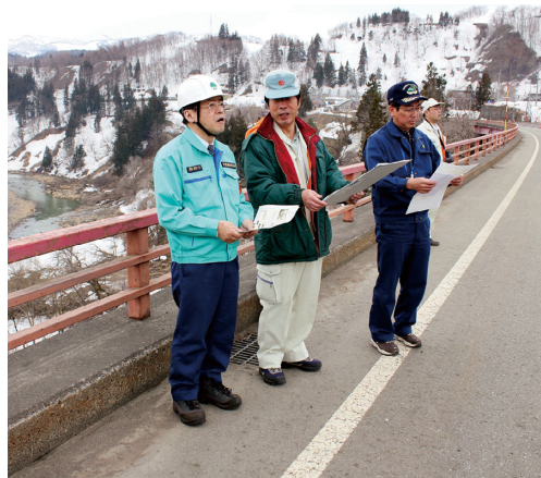
地震による被害状況を視察する局長
