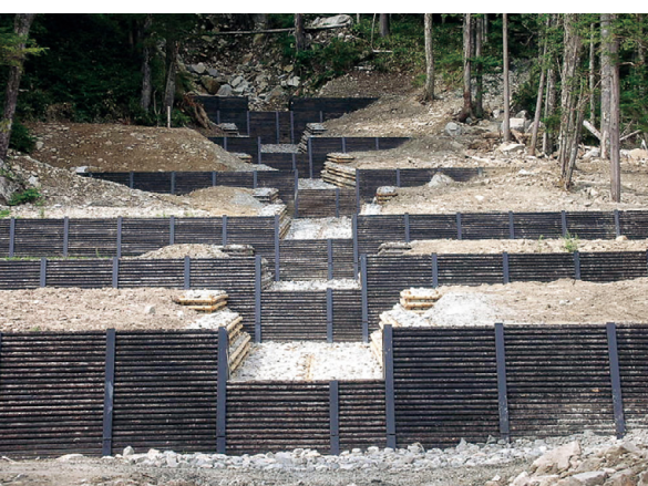
中信署の事例（善六沢復旧治山工事）
