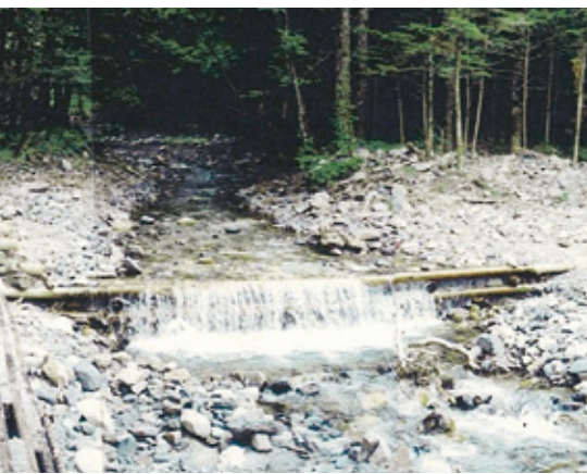
溪流の保全に配慮した工法 (中信署)
