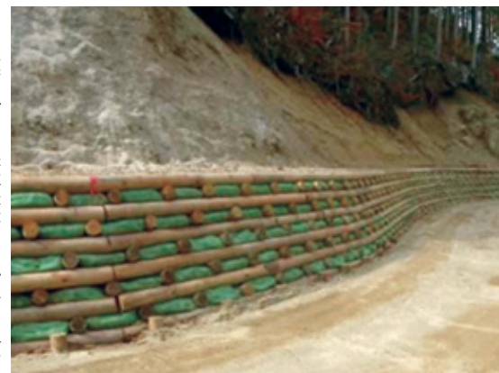
スギの間伐材を利用した路面基礎部の土留工 (木曽署)
