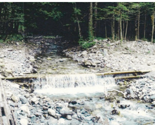
溪流の保全に配慮した工法 (中信署)
