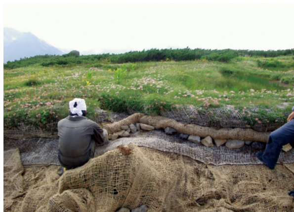
植生復元作業（崖箇所処理）
