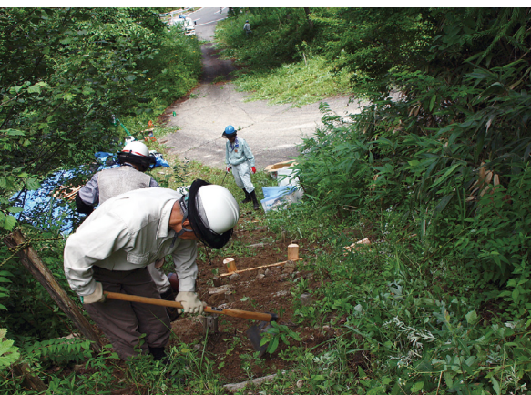
下刈りの他歩道の整備作業も実施
