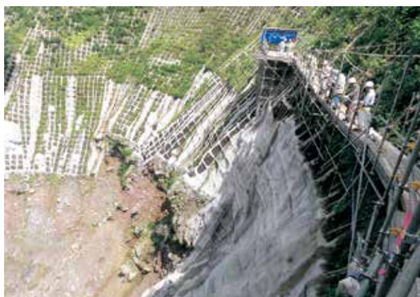
治山現場を上部から視察
