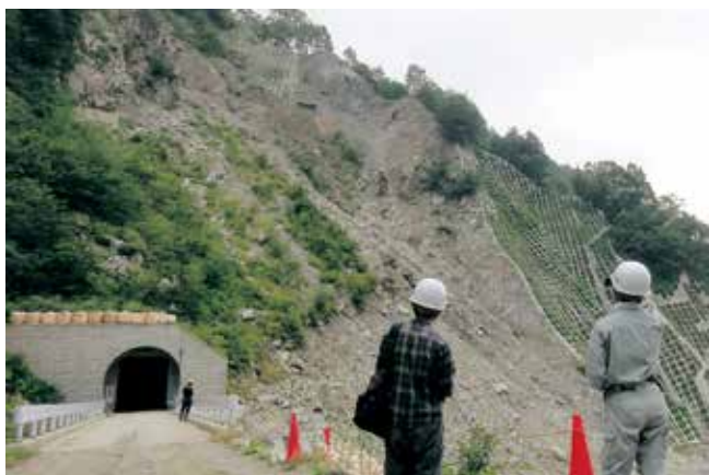
治山現場を下部から視察
