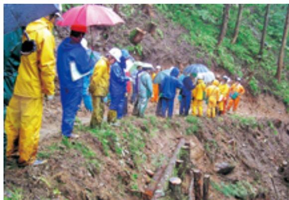
北信署独自の丸太とブルーシートを組み合わせた流水処理
