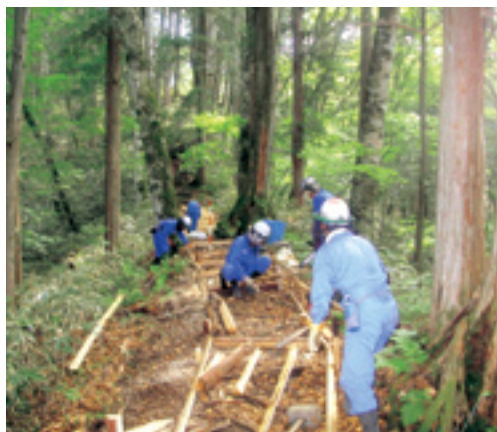
歩道修理作業中
