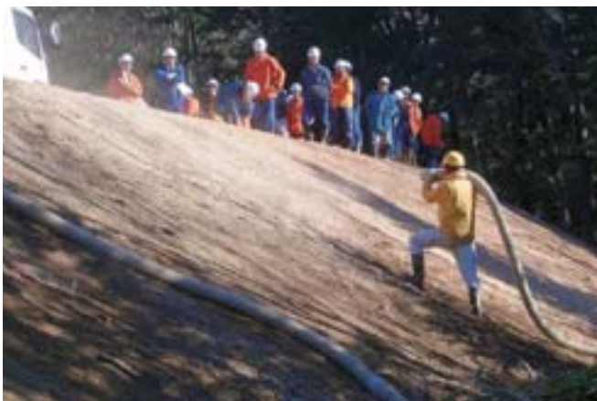
のり面吹付けの様子
