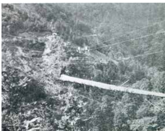
架線搬出中（広報「みどり」から）
