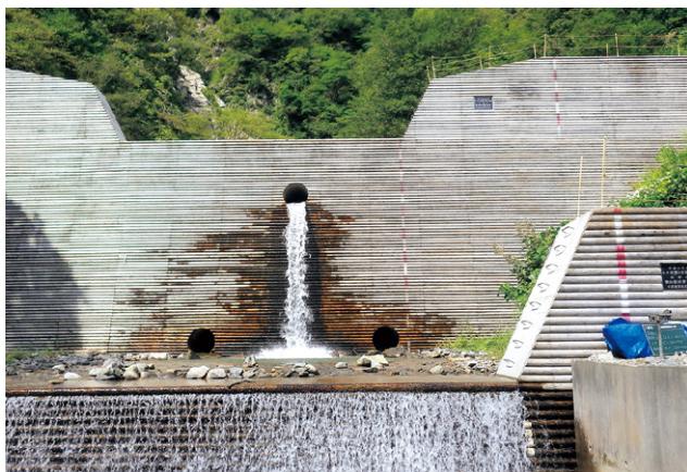
丸太残存型枠を使用した谷止工
