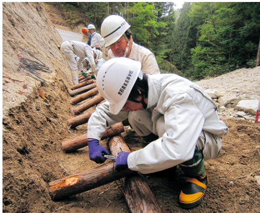
丸太筋工の施工を体験
