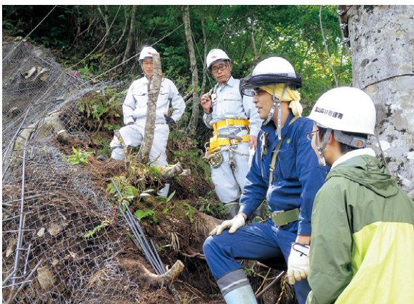
復旧治山工事現場視察
