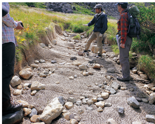
施工地の現地検討会
