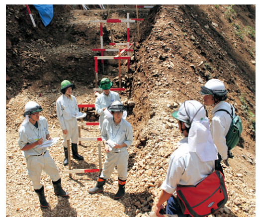
林道改良工事箇所の見学
