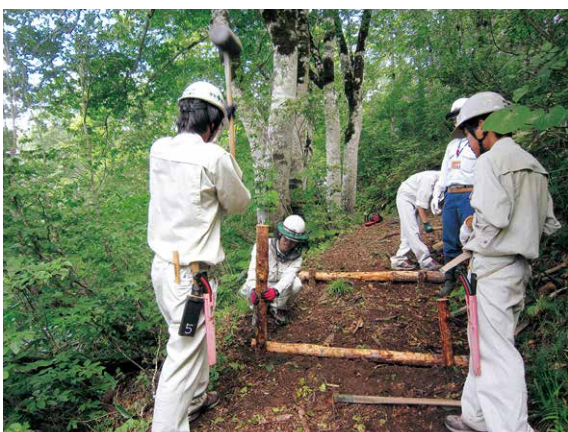
杭打ちを行う生徒たち
