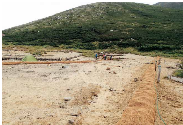
土留工(50m×2列)を施工
