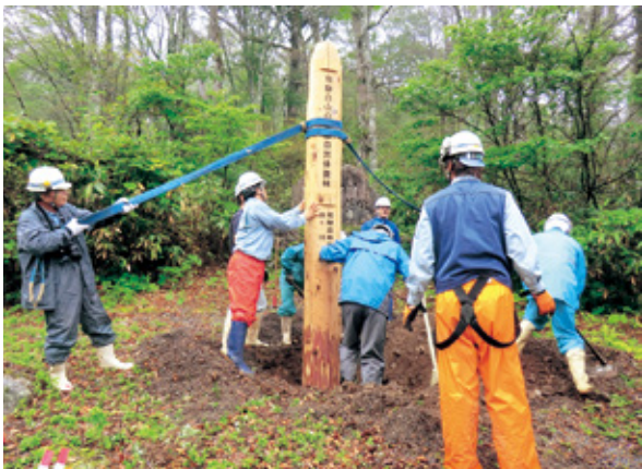
「飛騨白山白川郷自然休養林」 標柱建込み作業
