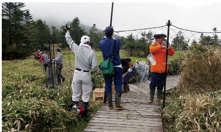
ニホンジカ防護ネット設置の様子
