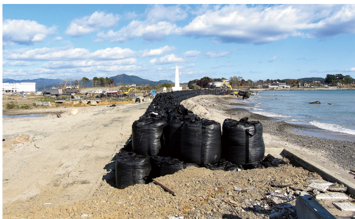
応急対策実施後の様子（現在）
