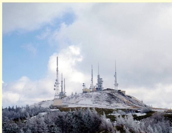
王ヶ頭付近の電波塔群
