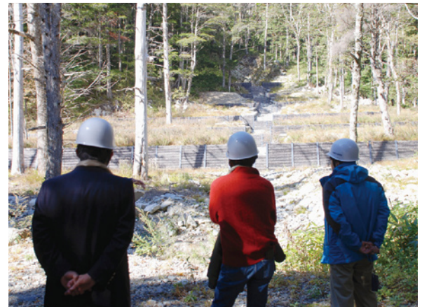
善六沢の鋼製柵土留工施工地
