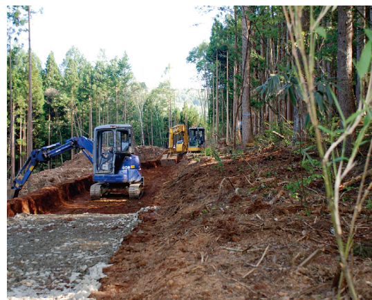
飛騨署において作設中の林業専用道
