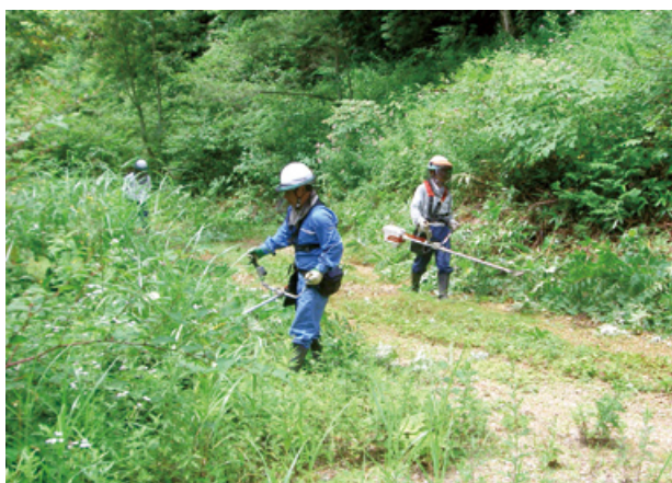
林道刈払いの様子
