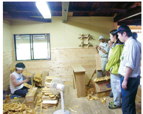
屋根葺き材のこけら製作
