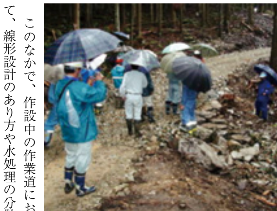
現地資材（転石）を活用した洗い越し
