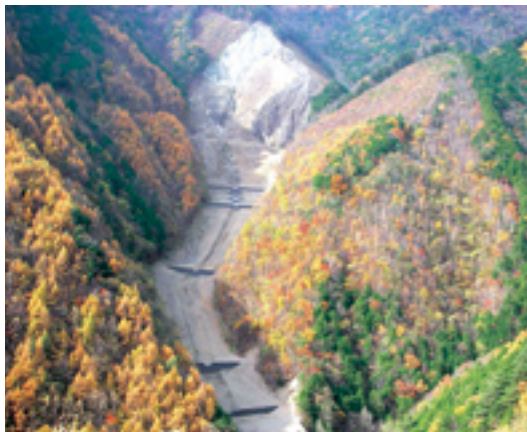
豪雨災害箇所の復旧対策の実施 (南信署)
