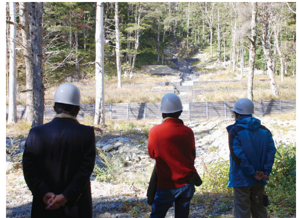
善六沢の鋼製柵土留工施工地
