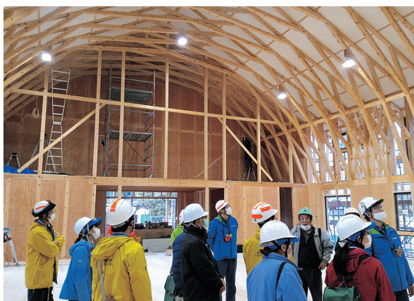
建設中の妻籠町並み交流センターの見学
