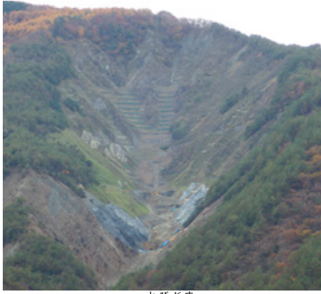
とびがす 復旧が進む鳶ヶ巣大崩壊地
