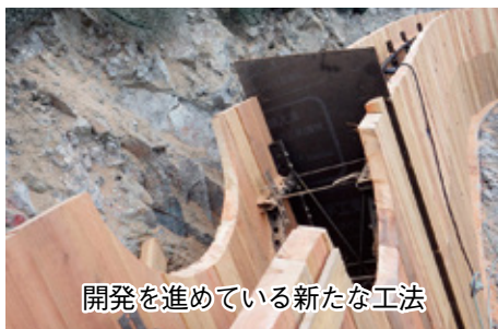
地すべり活動を抑制する排水トンネル
