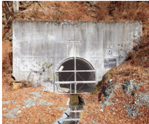
地すべり活動を抑制する排水トンネル
