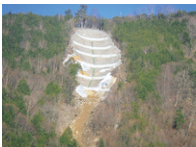
畑沢復旧治山工事 中部森林管理局長賞 この工事は、資材の搬入に490mもの索道を用いることから、毎週末に週間工程表を作成して進捗率を把握し、工期を2箇月短縮させた山腹工事でした。
