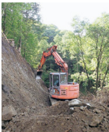
のり面掘削の様子
