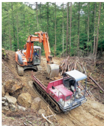
掘削した土砂を運ぶ様子
