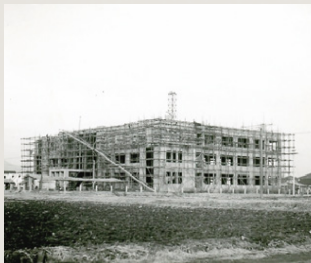
昭和30年頃 建設途中の長野営林局庁舎
