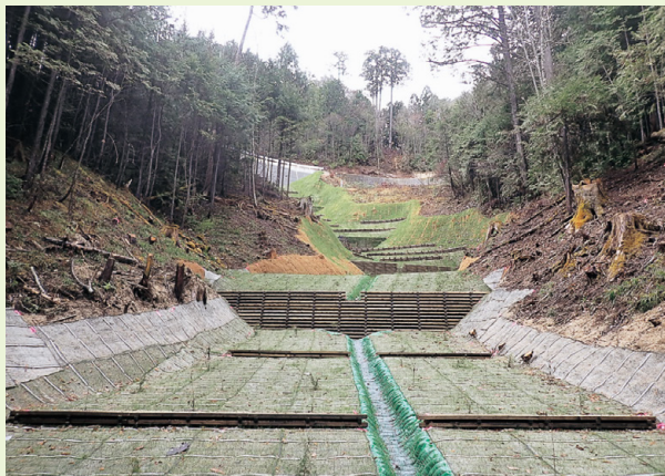
トヤノ沢復旧治山工事 施工者 奥田工業(株)
