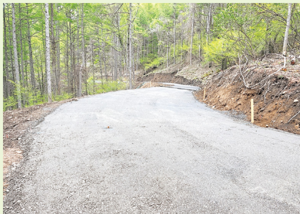
大門本沢林業専用道新設ほか工事 施工者 (株)羽田組
