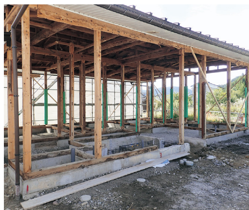
躯体のみとなった森林事務所
