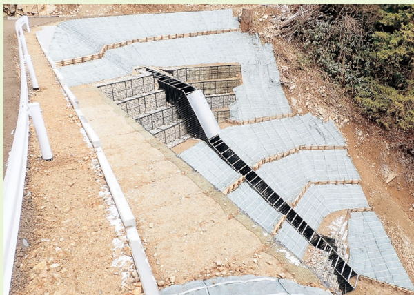
一ノ瀬林道災害復旧工事 施工者 (株)梅田組
