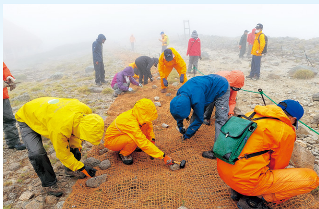
小雨の降る中での植生マット敷設作業
