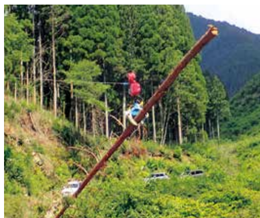
架線式グラップルで伐倒木を運搬する様子
