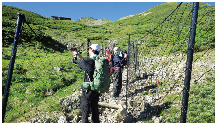
ボランティアによる防鹿柵の設置
