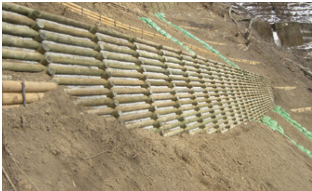
中部森林管理局長賞 長野県松本地域振興局 山腹工（校倉式木製土留工）
