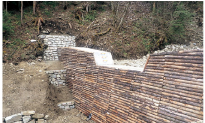
長野県知事賞 木曾森林管理署南木曾支署 谷止工（木製残存型柵）
