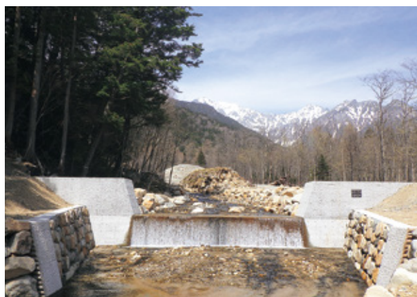
令和4年度の施工箇所
