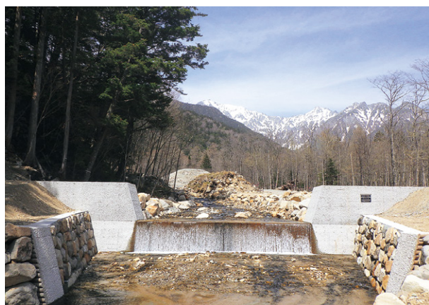
令和4年度の施工箇所
