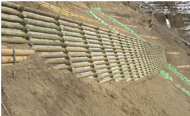
中部森林管理局長賞 長野県松本地域振興局 山腹工（校倉式木製土留工）
