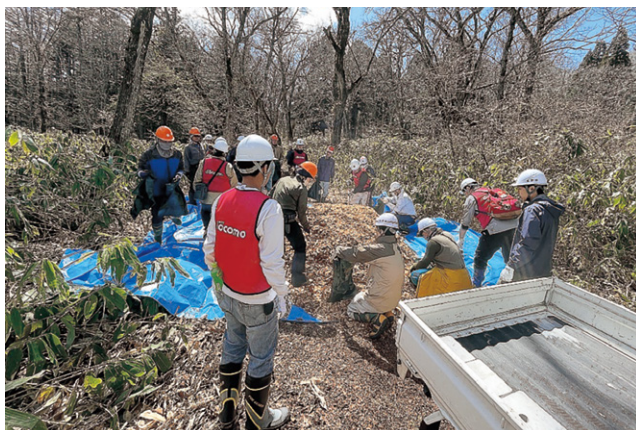
ウッドチップ敷設作業
