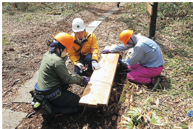
園内のベンチの補修
