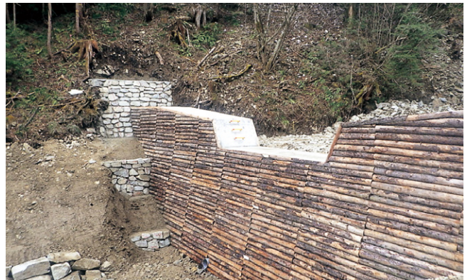
長野県知事賞 木曾森林管理署南木曾支署 谷止工（木製残存型柵）
