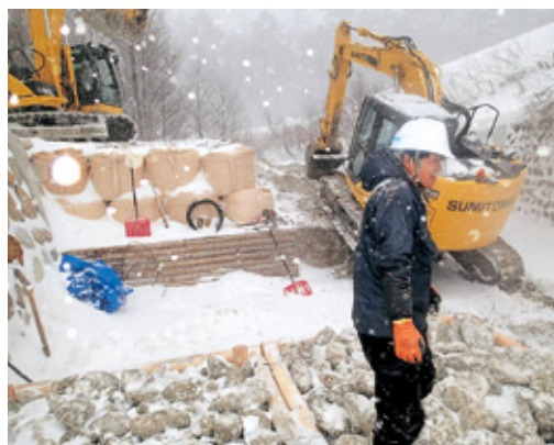
山間地帯の気象変動は激しく、吹雪の中作業の様子
