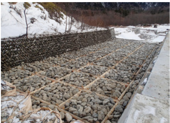
完成した、河床の洗掘防止のための木工沈床工の様子
