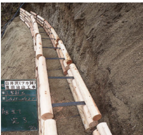
L型筋工 組立状況
