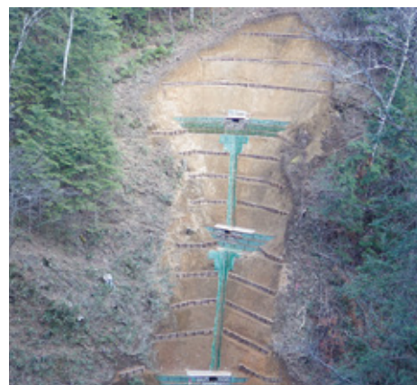
ほづきさわ 小膳沢 (小膳沢) 復旧治山工事
