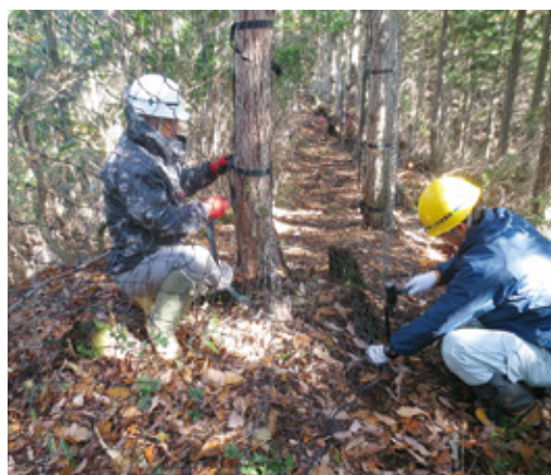
獣害防護柵 施工状況
