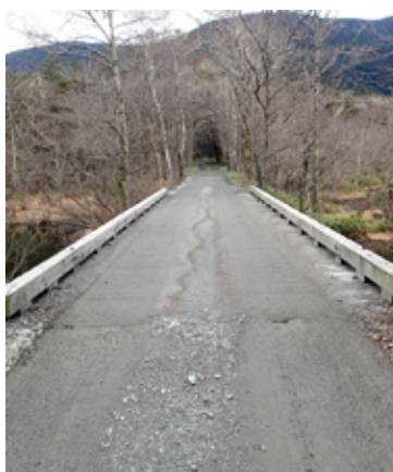
完成した治山運搬路の木橋
